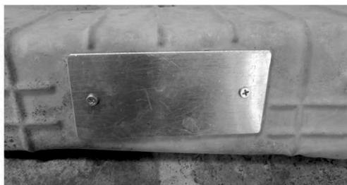
4. Закрыть отверстие от патрубка выхода вариатора заглушкой поз.8, крепить винтами М4х20 поз.14 и дюбелями М4 поз. 18 через шайбы 4 поз.20 и 21.
